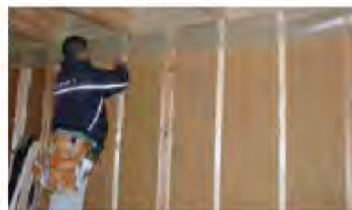
断熱材の施工の様子
