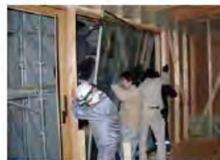
取付工事中のトリプルサッシ
