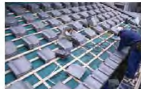
テラスの屋根に瓦を葺いている様子
